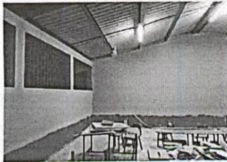
Foto: 3 Vista de la Pintura en paredes del módulo 1
