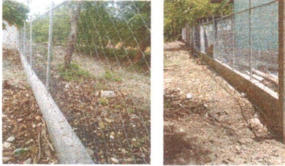
Foto1: Sustitución de malla en muro perimetra
