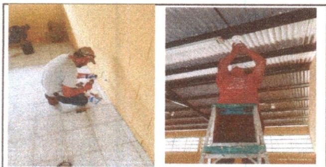
Foto 5: Sustitución de focos ahorradores, tomacorrientes dobles y plafonera
