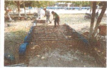
Foto 2: En proceso la reparación del balcón.
