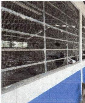
Foto 3: EN LAS AULAS A Y B, LAS MALLAS DE LAS VENTANAS ESTÁN DETERIORADAS Y PRESENTAN ÓXIDO.
