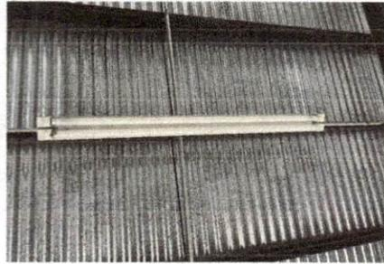
Foto 2: LAS AULAS A Y B TIENEN PLAFONERAS EN MAL ESTADO Y GASNEONES QUEMADOS
