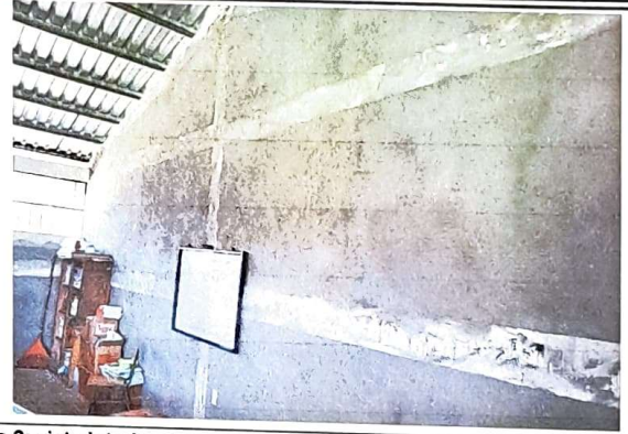
Foto 2: vista interior de modulo 1, se aprecia la aplicación de repello en muros
