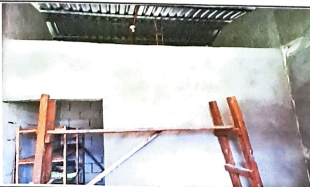
Foto 5: vista interior de modulo 1, dirección se aprecia el remozamiento en muros
