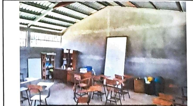
Foto 12: vista interior de modulo 1, se observa la base para la instalación de piso de granito
