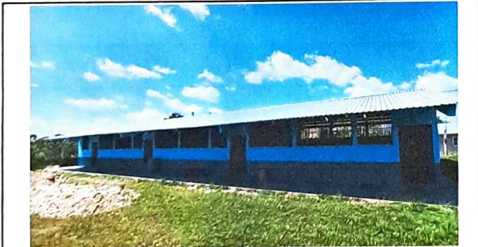
Foto 9: vista frontal de modulo 1, se observa el trabajo de pintura en muros
