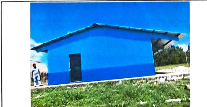
Foto 11: vista lateral de modulo 1, observa la aplicación de pintura en muros
