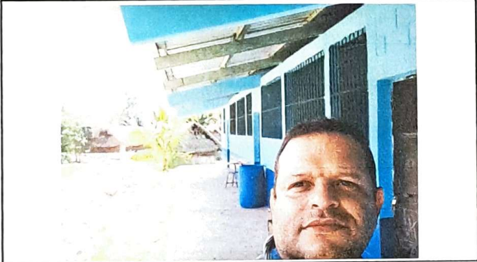
Foto 7: vista de pasillo modulo 1, se aprecian los trabajos de pintura en muros
