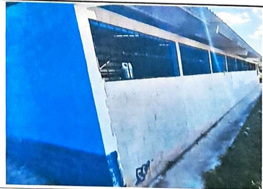
Foto 6: vista exterior de modulo 1, se aprecia el proceso de pintura en el modulo
