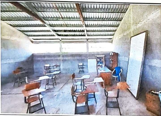
Foto 3: vista interior de modulo 1 se aprecia el trabajo de remozamiento en muros
