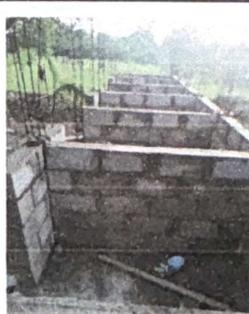
Foto 6: LEVANTADO DE MURO PARA BAÑOS
