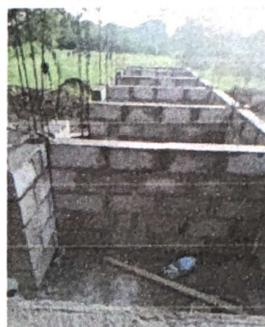
Foto 2: LEVANTADO DE MURO PARA BAÑOS
