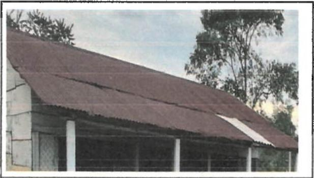
Foto 3: TECHO DE AULA (A), TECHO DE LAMINA CON AGUJEROS Y ESTRUCTURA EN MAL ESTADO.
