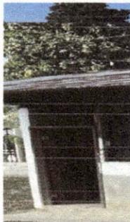
Foto 5: AULA (A), PUERTA DE MADERA CON PRESENCIA DE HUMEDAD, BISAGRAS EN MAL ESTADO Y SIN CERRADURA.
