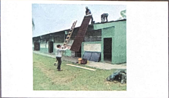
Foto 1: INSTALACION DE LAMINA
