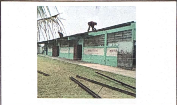
Foto 2: INSTALACION DE LAMINA
