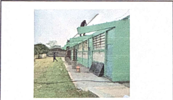
Foto 3: INSTALACION DE ESTRUCTURA METALICA
