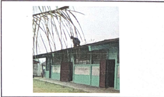
Foto 6: INSTALACION DE LAMINA.
