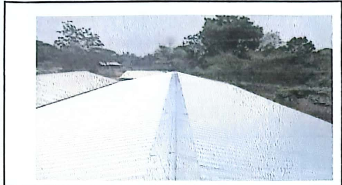
foto1 1.1 sustitucion de lamina, por lamina troquelada aluzimc calibre 26
