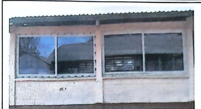
foto 2. 5.5 sustitucion de vidrio
