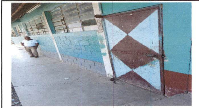
Foto 3: Sustitución de puerta
