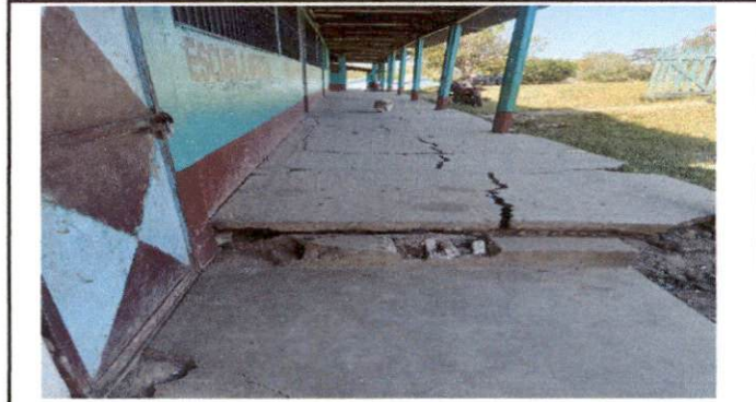
Foto 4: Preparación de piso de torta de concreto.
