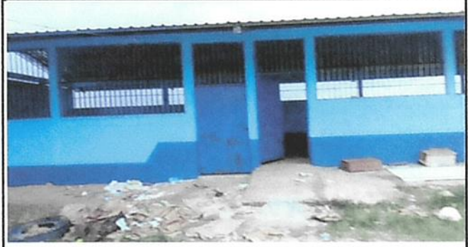
Foto 2: Sustitución de piso cemento líquido
