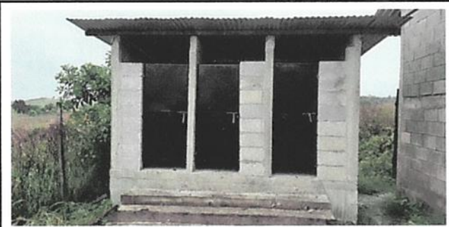
Foto 5: Fabricación e instalación de puertas metálica en baños
