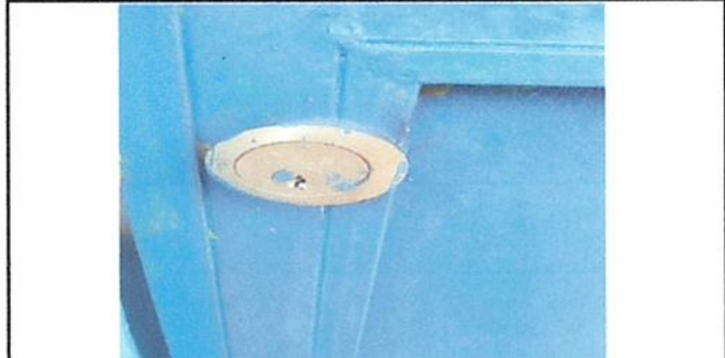
Foto 6: Sustitución de chapas para puertas
