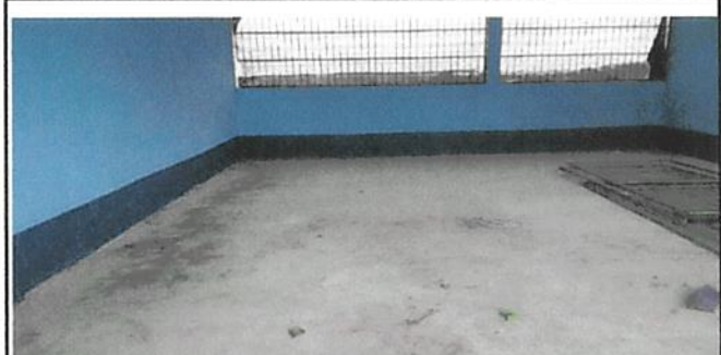
Foto 4: Sustitución de piso cemento líquido
