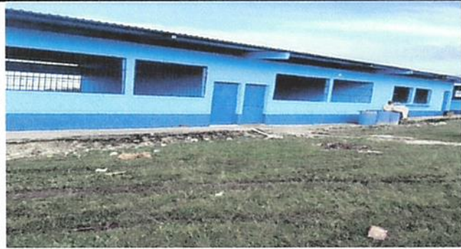
Foto 1: Sustitución de ventanas estructuras metálica
