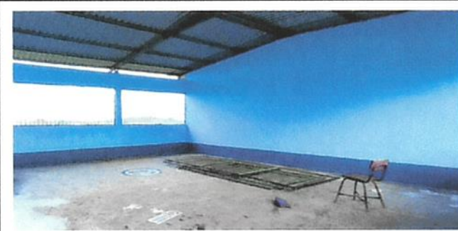
Foto 3: Sustitución de piso cemento líquido
