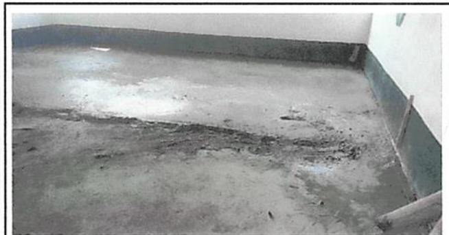
Foto 3: Sustitución de piso cemento líquido
