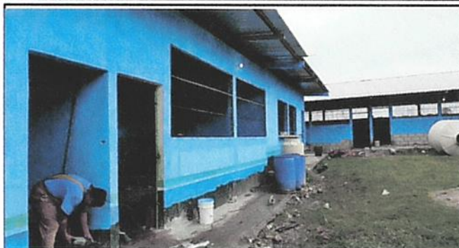
Foto 1: Sustitución de ventanas estructuras metálica
