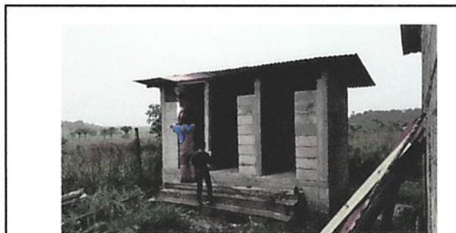
Foto 5: Fabricación e instalación de puertas metálica en baños
