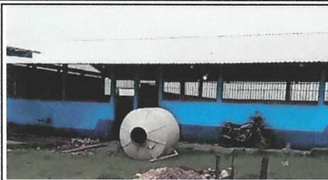
Foto 2: Sustitución de piso cemento líquido
