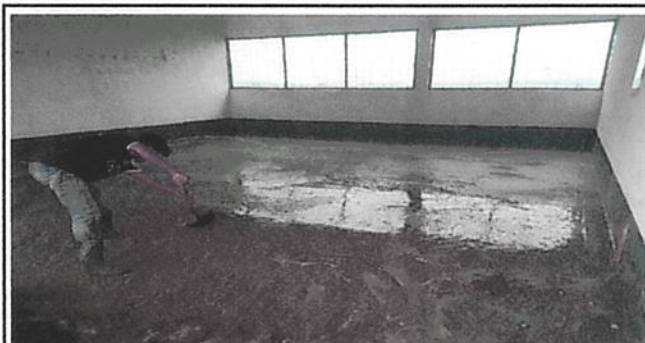
Foto 4: Sustitución de piso cemento líquido
