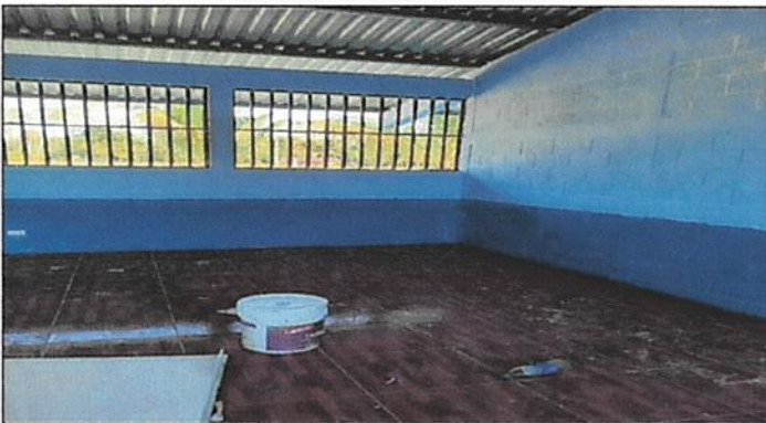
Foto 3: Pintura en muros interiores
