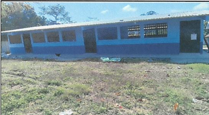
Foto1: Pintura en muros exteriores
