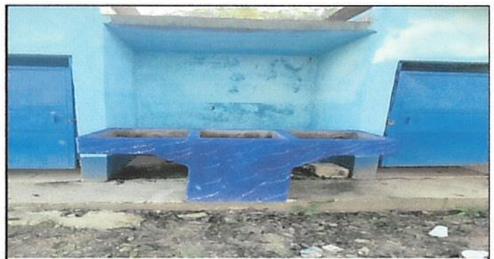
Foto 6: Sustitucion de pila de concreto de dos lavaderos
