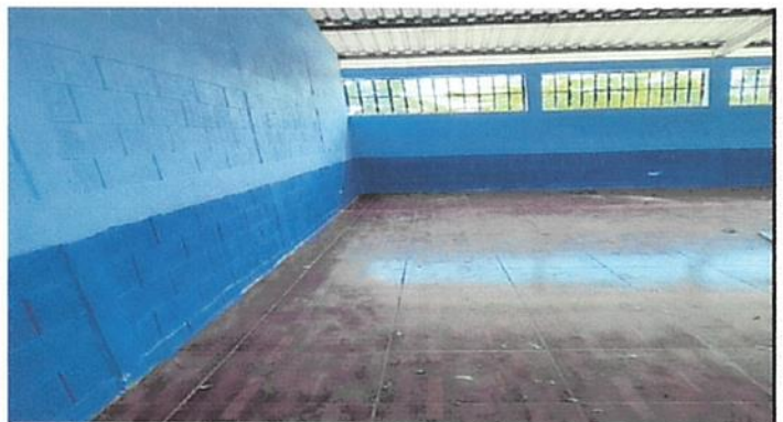
Foto 4: Sustitucion de piso de torta de concreto
