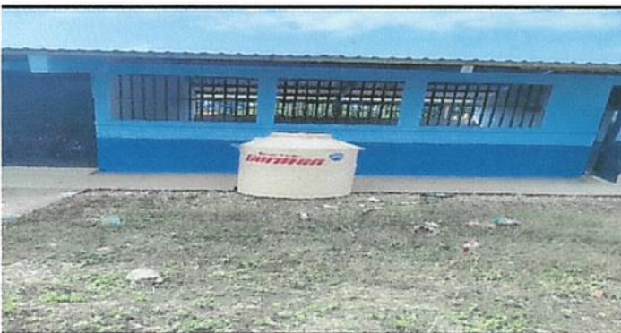
Foto 5: Sustitucion de deposito de agua de 1100 lt
