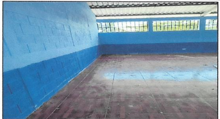
Foto 2: Pintura en muros interiores
