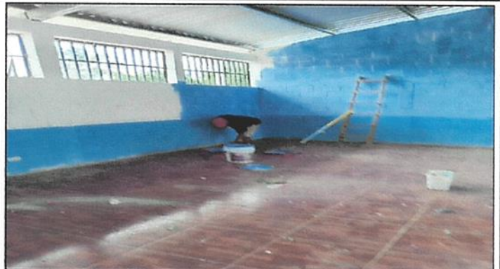
Foto 2: Pintura en muros interiores
