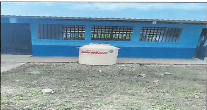
Foto 5: Sustitucion de deposito de agua de 1100 lt
