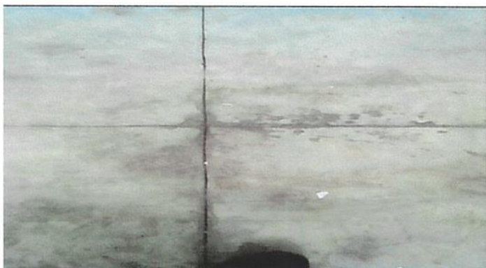
Foto 4: Sustitucion de piso de torta de concreto
