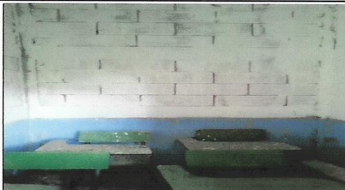
Foto 2: Pintura en muros interiores
