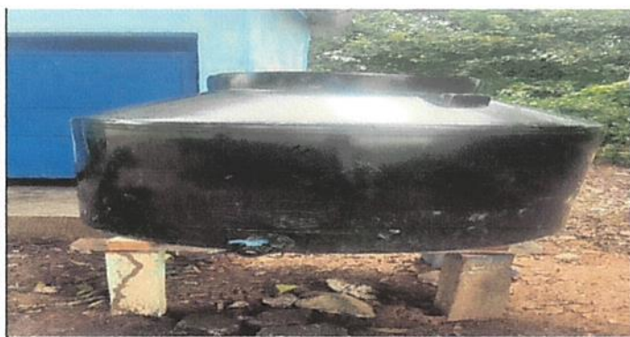
Foto 5: Sustitucion de deposito de agua de 1100 LT
