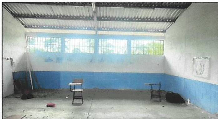
Foto 3: Pintura en muros interiores
