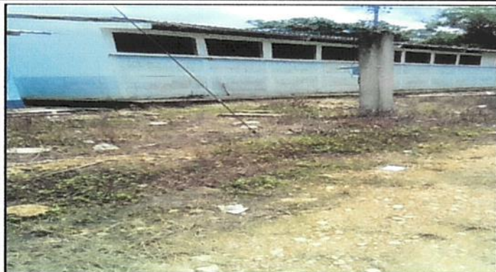
Foto1: Pintura en muros exteriores
