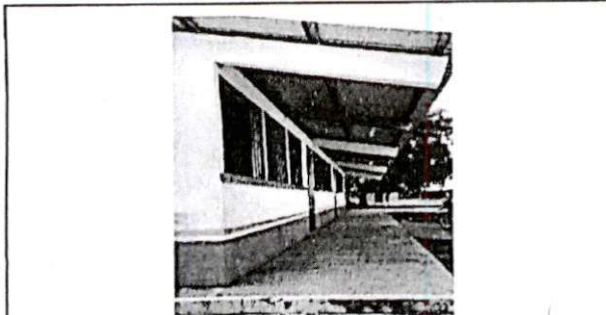
Foto 3: Corredor. Sustitución de piso de torta de concreto.
