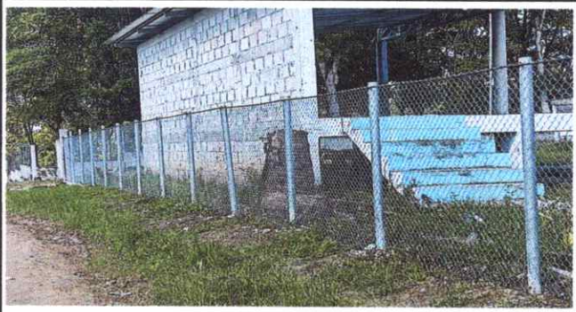
Foto 3: Renglón 15.3. Reparacion de tubo hg y malla galvanizada, para la circulacion del predio escolar para tener mas seguro, para el beneficio de la niñez-
