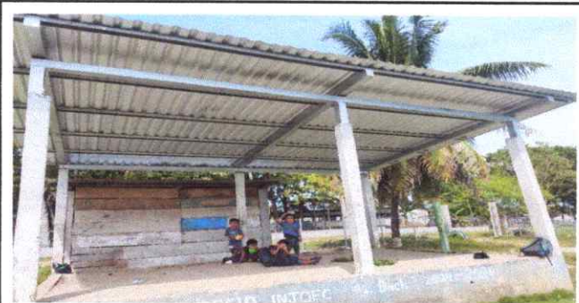
Foto 5: Renglón 1.1. Sustitucion de lamina. Por lámina troquelada aluzinc cal. 26. para la Escuela Oficial Rural Mixta, de San Jose Caribe.
