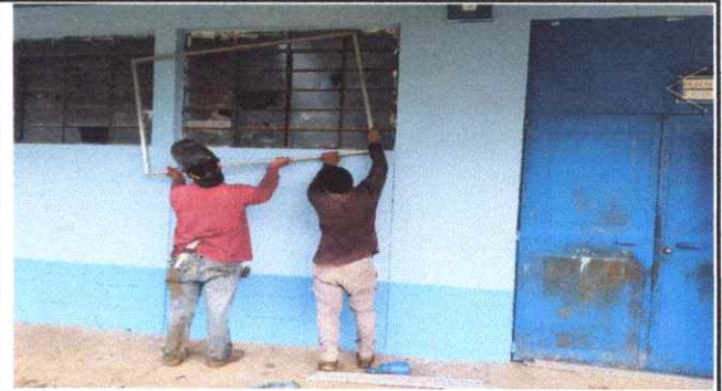
Foto 2: Renglón 5.6. Posteriormente este trabajo fue la sustitucion de los balcones.
