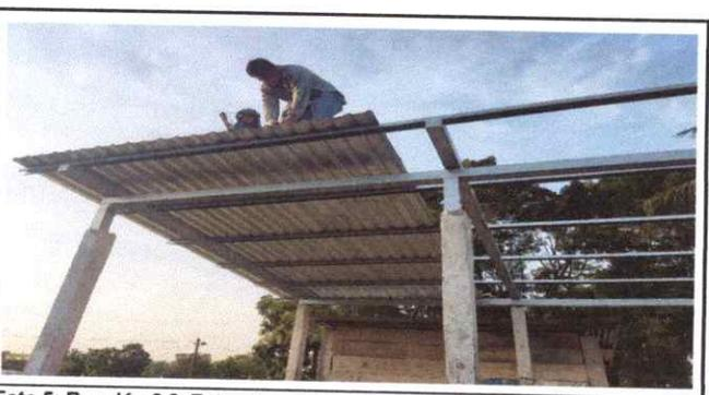
Foto 5: Renglón 2.2. Estructura de Techo, fue la sustitución de soporte de madera, por metal.
