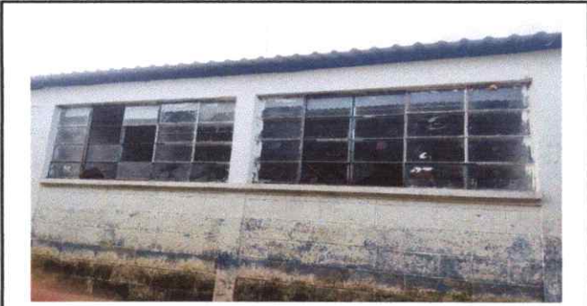
Foto1: Instalaciones de balcones de metal de la EORM.Fis Renglón No. 5.6.
