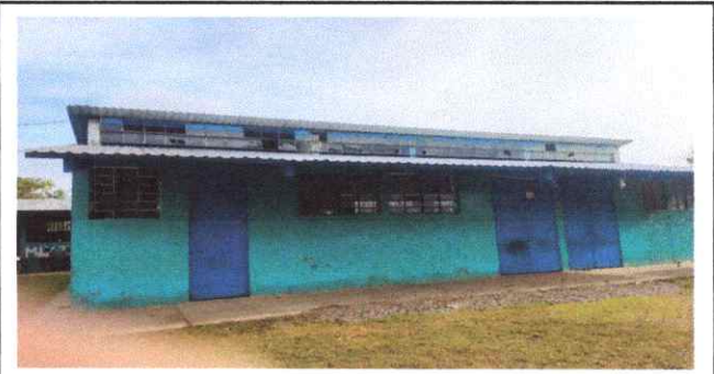
Foto 2: Pintar las paredes interiores y exteriores No. 9.1
