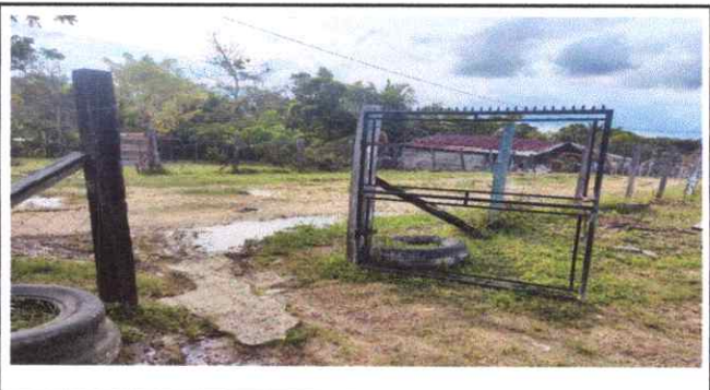
Foto 4: Fabricación e instalación de porton de metal con poste de concreto metal. 19.5
