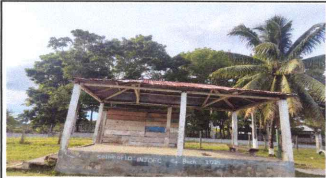
Foto 3: Renglón No.1.1- Sustitucion de lámina, por lámina troquelada aluzinc cal. 26.
