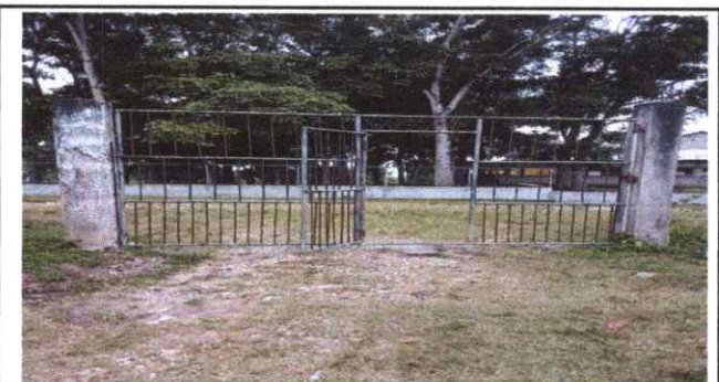
Foto 6: Mantenimiento de portones de metal. De la Escuela San José Caribe. Renglón 12.1
