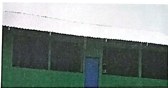
Foto 3: Cuando ya está arreglado la lamina
