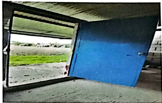
Foto 2: Arreglando la puerta
