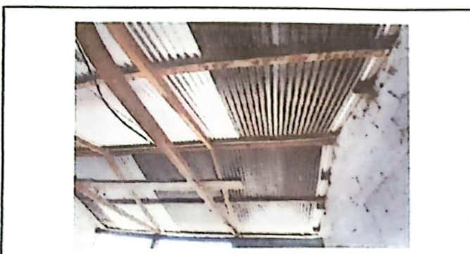
Foto 3: Sustituir el soporte de lamina y cambiar la lámina
