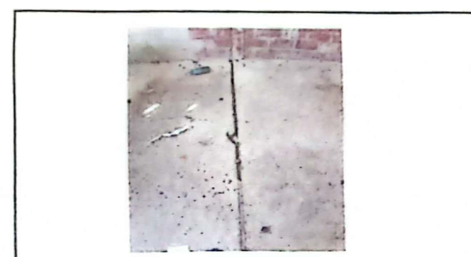
Foto 6: Arreglar el piso
