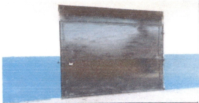
Foto 6: sustitucion de puerta nueva
