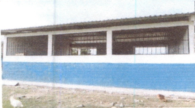
Foto 1: Se observa el cambio de techo
