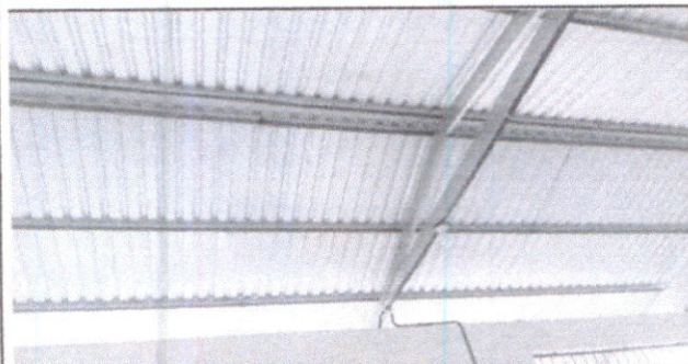
Foto 5: se observa el cambio de cableado para energia electrica
