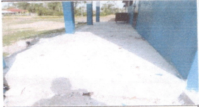
Foto 2: Se observan el repello de cemento para muro
