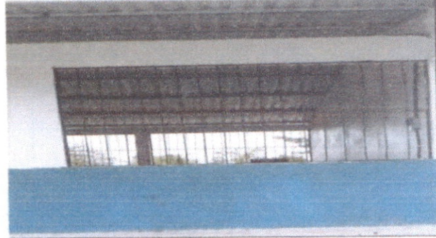
Foto 4: se observa la pintura para muro.
