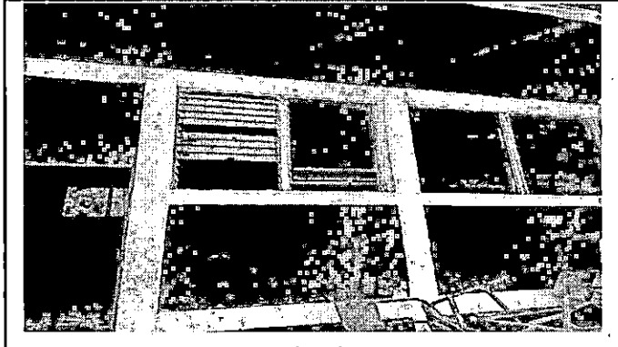
Foto 2: Reparación de Ventana
