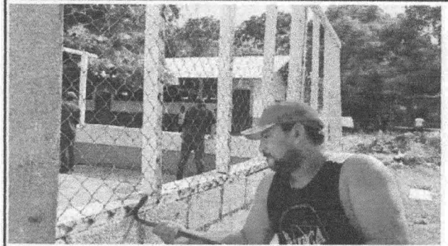
Foto 4: Ventanas de malla por metal
