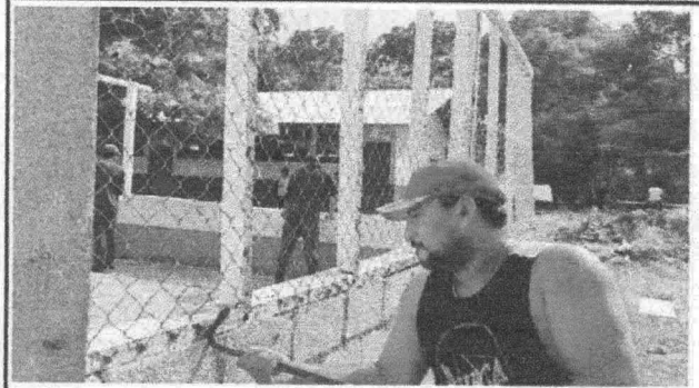
Foto 4: Ventanas de malla por metal
