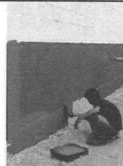
Foto 6: Pintura de muros exteriores e interiores
