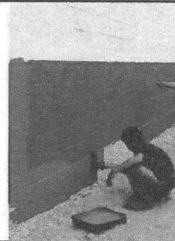
Foto 6: Pintura de muros exteriores e interiores
