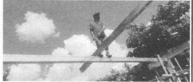
Foto 2: Estructura de Techo
