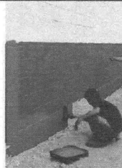
Foto 6: Pintura de muros exteriores e interiores
