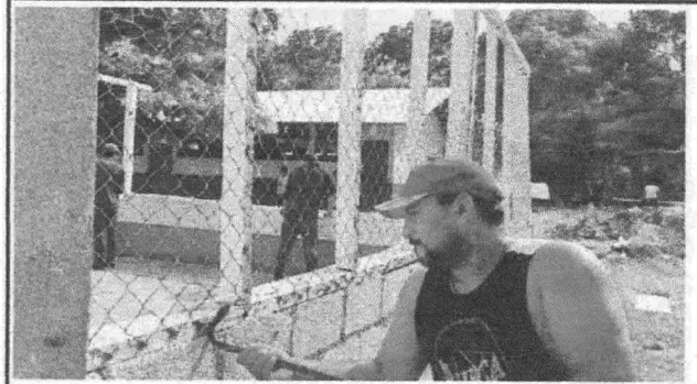
Foto 4: Ventanas de malla por metal
