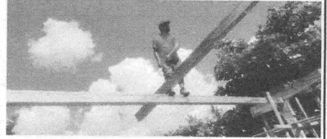
Foto 2: Estructura de Techo
