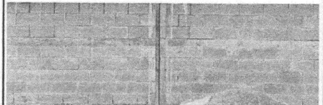
Foto 6: Muros exteriores e interiores sin pintar
