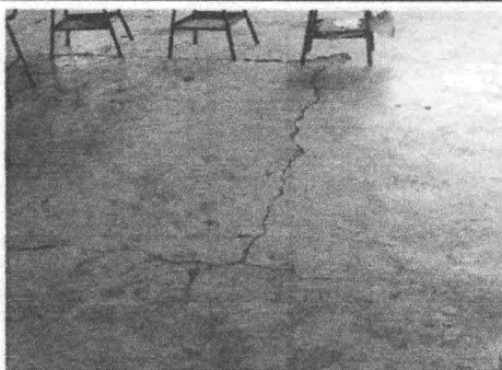
Foto 5: Reparación de piso de cemento
