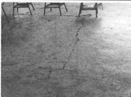
Foto 5: Reparación de piso de cemento
