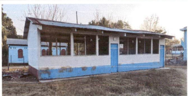
Foto 6: Susticion de puertas
