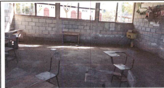
Foto 3: Pintura para interior del Edificio Escolar
