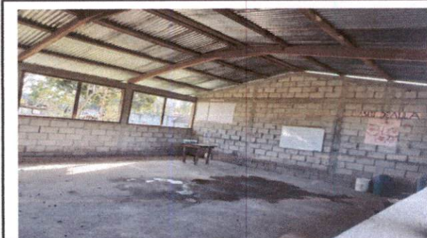
Foto 5: Cambio de Piso
