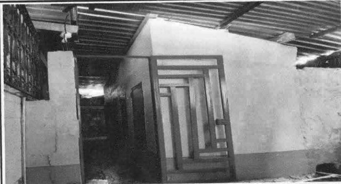
Foto 1: Repello en muro, columnas, pintura en muro exteriores e inferiores.
