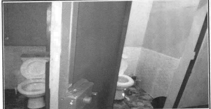
Foto 2: Sustitución de inodoros.
