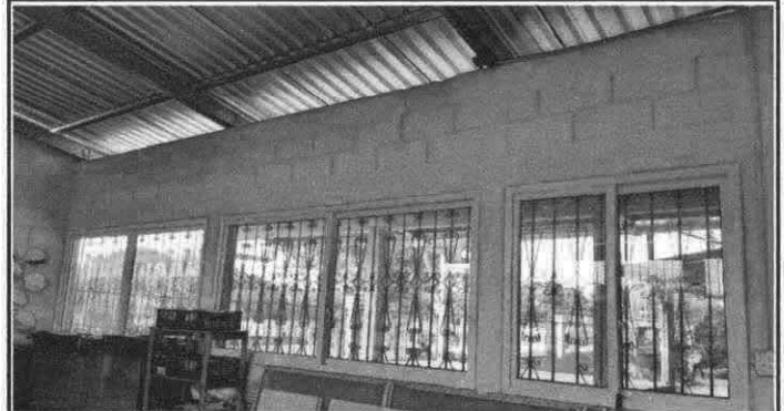
Foto 14: Sustitución de ventanas de madera por metal mas vidrio.
