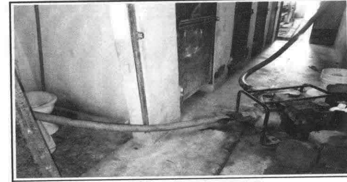
Foto 12: Limpieza de fosa séptica.
