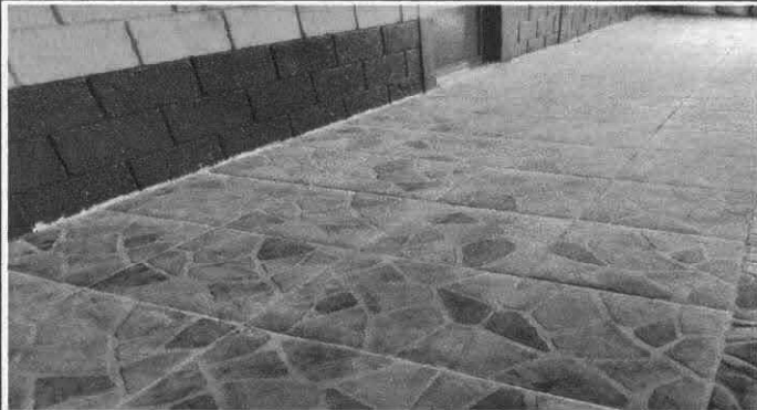
Foto 13: Sustitución de piso de cerámica.
