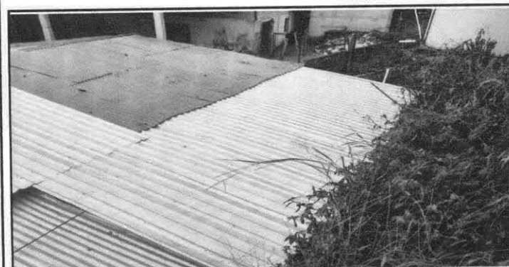
Foto 5: Sustitución de estructura de soporte de madera, por metal y sustitución de lámina, por lámina troquelada aluzinc calibre 26.
