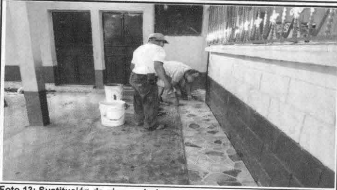
Foto 13: Sustitución de piso cerámico.
