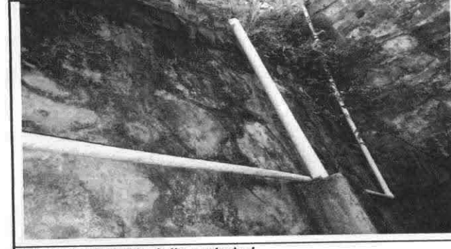
Foto 10: Sustruir tubería línea principal.
