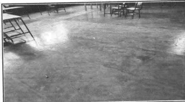
Foto 4: Sustitución de piso de torta de concreto a piso cerámico adentro de dos aulas.
