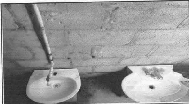
Foto 3: Sustitución de tres lavamanos.
