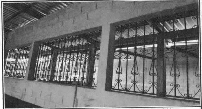
Foto 14: Sustitución de ventanas de madera por metal mas vidrio.
