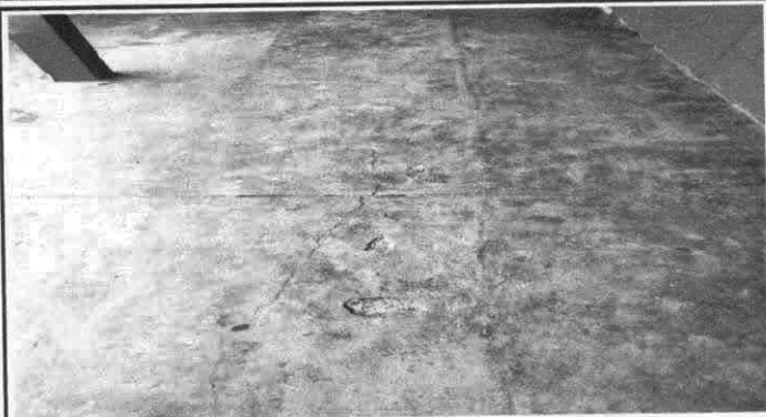
Foto 13: Sustitución de piso cerámico.
