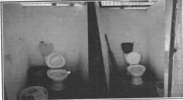
Foto 2: Sustitución de inodoros.
