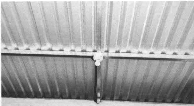
Foto 3: Sustitución de lámparas tipo LED
