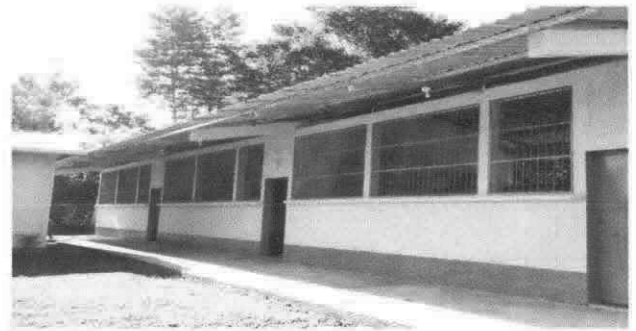
Foto 4: Pintura en muros exteriores e interiores
