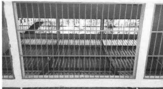
Foto 5: Sustitución de estructura de metal de ventana
