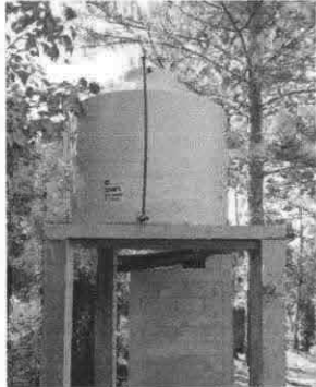
Foto 1: Sustitución de depósito de Agua 2500 Lts
