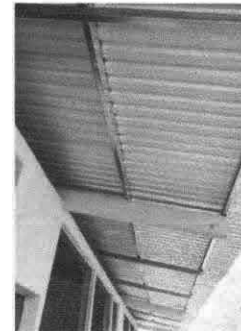
Foto 6: Sustitución de estructura de soporte de metal por metal
