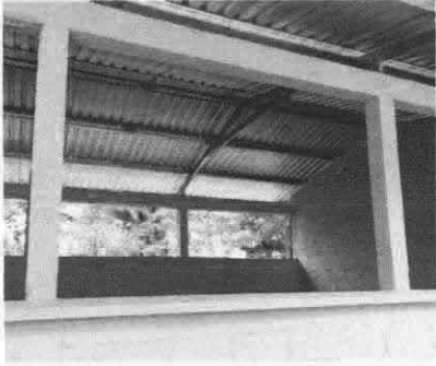
Foto 7: Sustitución de estructura de metal de ventana.
