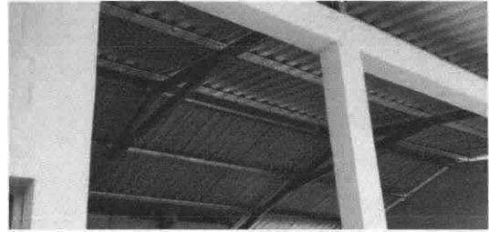
Foto 10: Sustitución de plafoneras
