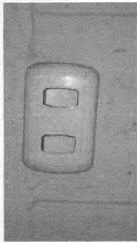
Foto 11: Sustitución de interruptores dobles
