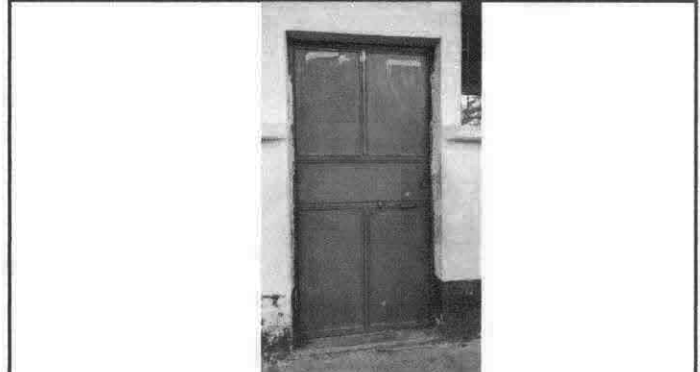
Foto 2: Mantenimiento a estructura lijado, cepillado y aplicación de pintura.
