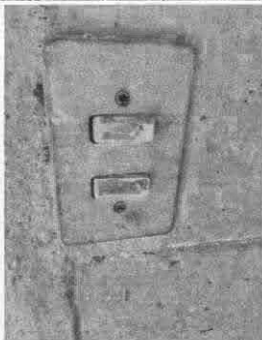
Foto 11: Sustitución de interruptores dobles
