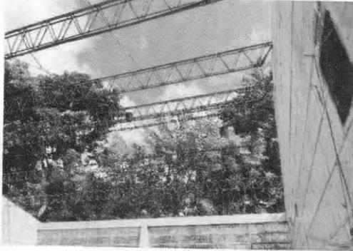
Foto 1: Sustitución de lámina por lámina troquelada alucin calibre 26.
