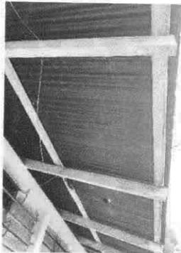
Foto 3: Sustitución de estructura de soporte de madera por metal.
