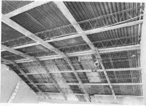
Foto 1: Sustitución de lámina por lámina troquelada alucin calibre 26.
