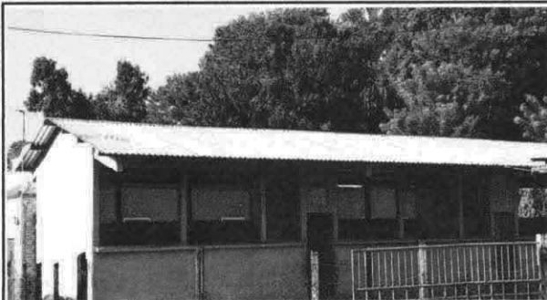
Foto 1: 3 Aulas: Sustitución de lamina, por lamina troquelada aluzin. Calibre 26.
