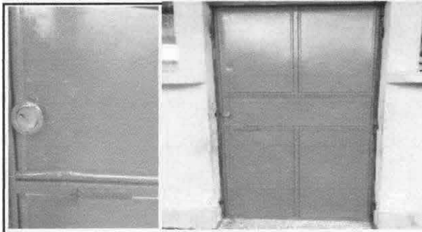
Foto 4: 3 puertas: Manteminiento, cambio de chapa, lijado y pintado.
