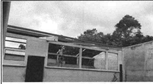
Foto 2: Mantenimiento de estructura, lijado, soldadura de costaneras, sujeciones, aplicación de pintura.
