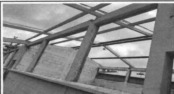
Foto 3: Aulas total 3 sustitución de balcones de metal.
