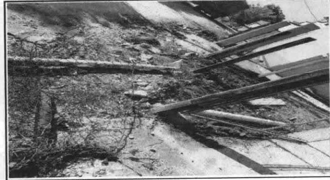
Foto 10: Sustitución de malla galvanizada.
