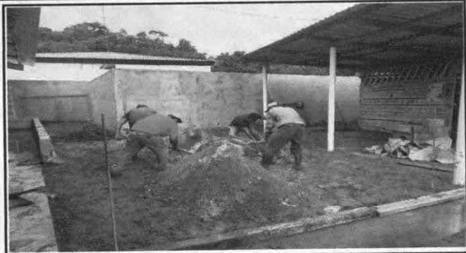
Foto 7: Sustitución de piso de torta de concreto.
