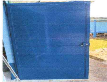
Foto 2: Mantenimiento a estructura de puertas.
