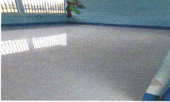
Foto 2: Sustitucion de piso de torta de concreto.
