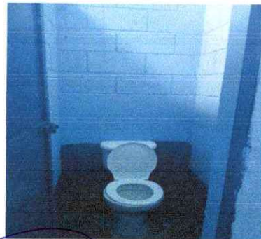
Foto 6: Sustitución de inodoros.
