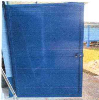
Foto 5: Sustitución de chapa.
