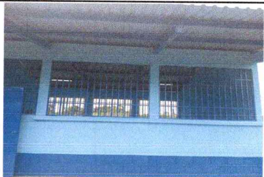
Foto 4: Sustitucion de estructura de metal de ventana .
