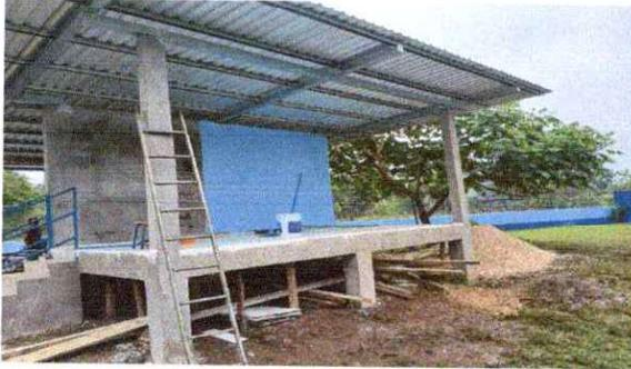
Foto1: Sustitución de lamina, por lámina troquelada aluzin calibre 26.
