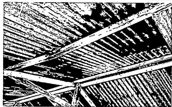
Foto 4: sustitucion de techo y soporte de madera por metal
