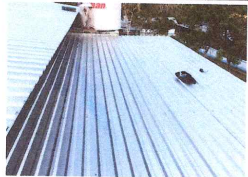
Foto 2: Finalización de instalación de lámina alucin calibre 26 para baños
