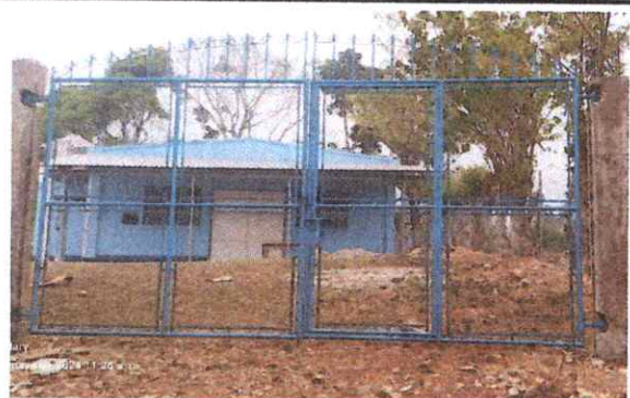
Foto 8: Portón de ingreso instalado.
