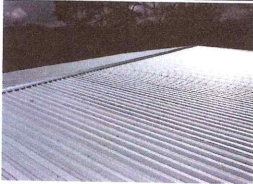
Foto 1: Finalización de instalación de techo de aulas.
