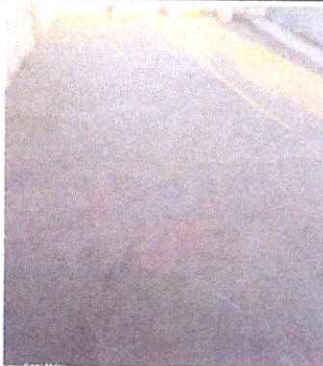
Foto 9: Piso de concreto de cocina finalizado.
