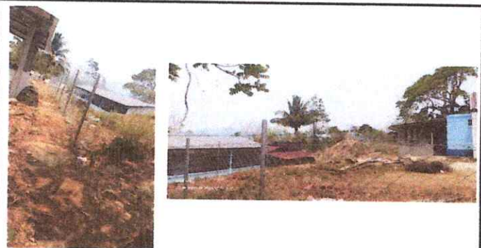
Foto 6: Finalización de instalación de malla metálica.
