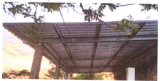
Foto 4: Finalización de instalación de techo de cocina con estructuras metálicas.
