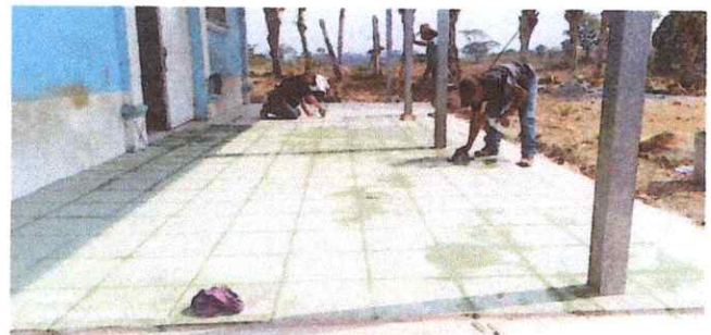
Foto 10: Piso cerámico antideslizante instalado.
