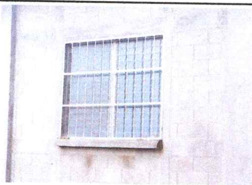
Foto 5: Paletas de vidrio de ventana instalada.
