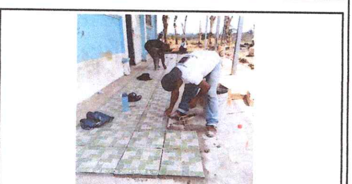
Foto 12: Instalación de piso cerámico.
