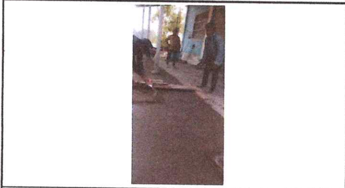
Foto 7: Sustitución de de piso.
