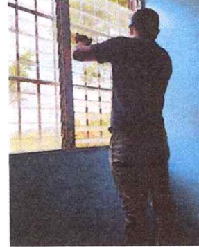
Foto 14: Instalación de paleta de vidrio para ventana.
