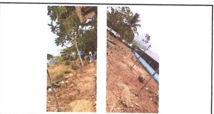
Foto 11: Sustitución de tubos metálicos para malla metalica.
