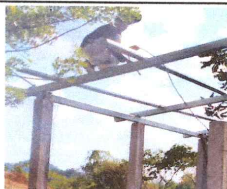
Foto 4: Instalación de techo de cocina con estructuras metálicas.
