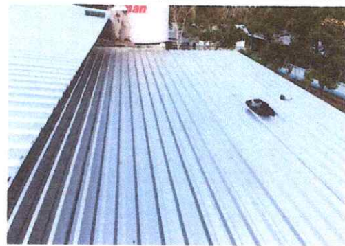
Foto 2: Instalación de lámina aluzinc calibre 26 para baños
