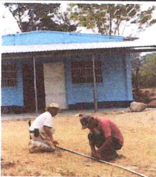
Foto 5: Instalación de tubo de agua.
