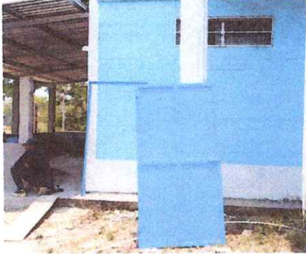
Foto 13: Instalación de puerta metálica de cocina.
