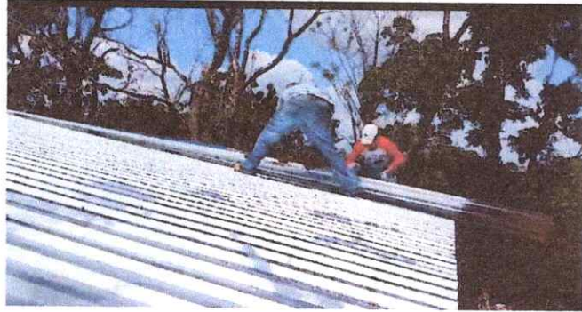
Foto1: Instalación de lámina troquelada Aluzinc calibre 26.
