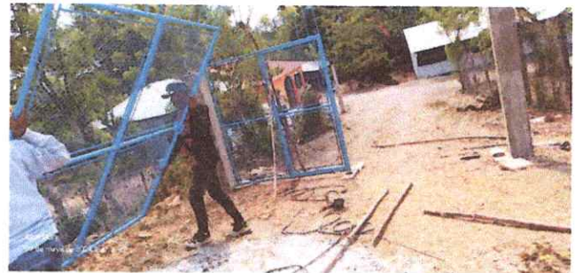
Foto 6: Instalación de portón de la EODP Caserío Joventé.
