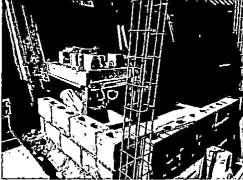
Foto1: Reparación de pila y seguimiento a columnas para colocación de balcones.
