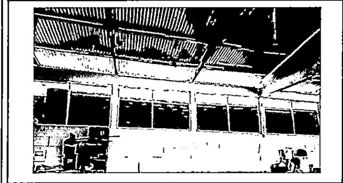
Foto1: Sustitución de laminas por balcones de metal y ventanas corredizas
