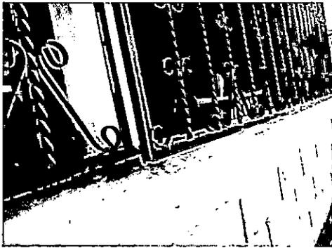
Foto 3: Reparación de balcones (soldar algunos pines)
