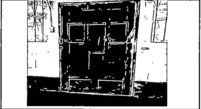
Foto 2: Sustitucion de puerta de madera por puerta de metal.
