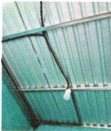
Fotografía 9: Instalación de Unidad de Luz
