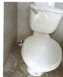
Foto 6: Sustitucion de accesorios de inodoro
