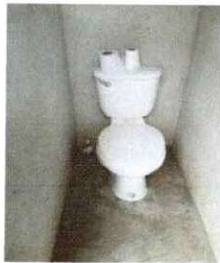
Foto 5: Sustitución de accesorios de inodoro
