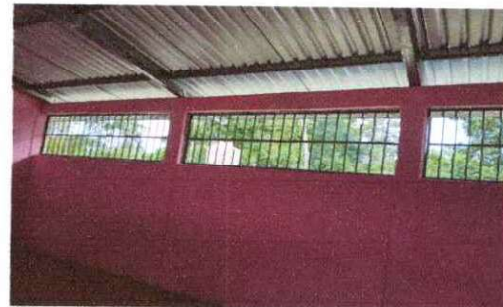
Foto 4: Fabricación e instalación de balcones de hierro
