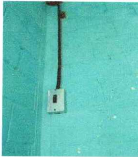
Fotografía 7: Sustitución de filipon
