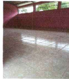
Foto 10: sustitución de Piso por ceramica
