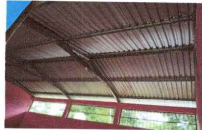
Foto 2: Sustitución de estructura de soporte de madera por metal
