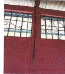
Fotografía 8: Sustitucion de accesorios de energia
