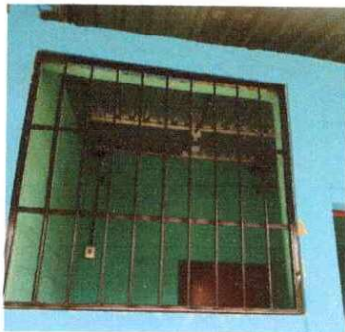
Foto 3: Fabricación e instalacion de balcon de hierro por
