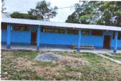
Foto 1: sustitución de lámina por lámina troquelada
