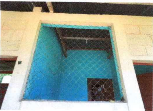
Foto 3: Fabricación e instalación de balcón de hierro por
