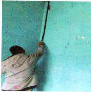
Fotografía 7: Sustitución de filipon
