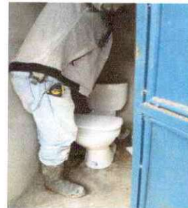
Foto 6: Sustitución de accesorios de inodoro
