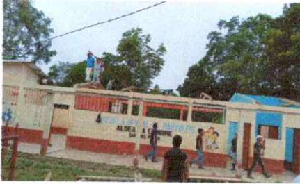
Foto 1: sustitución de lámina por lámina troquelada
