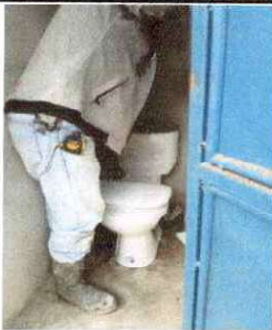
Foto 5: Sustitución de accesorios de inodoro
