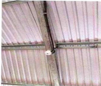
Fotografía 9: Instalación de Unidad de Luz
