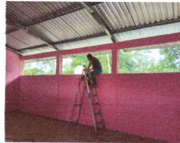
Foto 4: Fabricación e instalación de balcones de hierro
