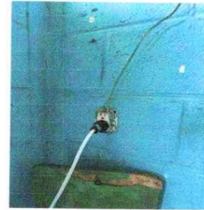
Fotografía 8: Sustitucion de accesorios de energia
