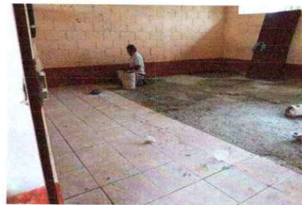
Foto: Sustitución de piso por ceramica
