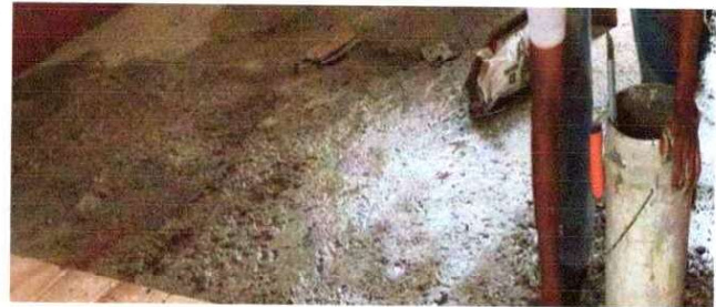
Foto 10: sustitución de torta de concreto
