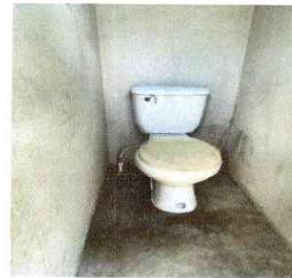
Foto 6: Sustitucion de accesorios de inodoro
