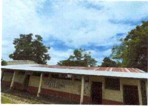
Foto 1: sustitución de lámina por lámina troquelada
