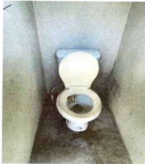
Foto 5: Sustitución de accesorios de inodoro
