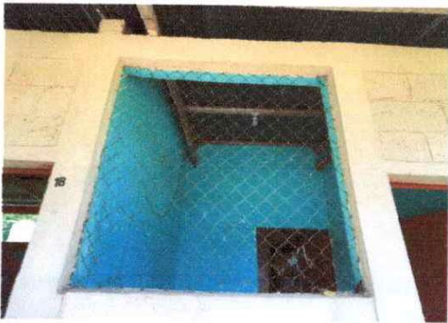
Foto 3: Fabricación e instalacion de balcon de hierro por
