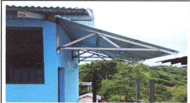
Foto 3: SUSTITUCIÓN DE LAMINA POR LAMINA TROQUELADA CALIBRE 26
