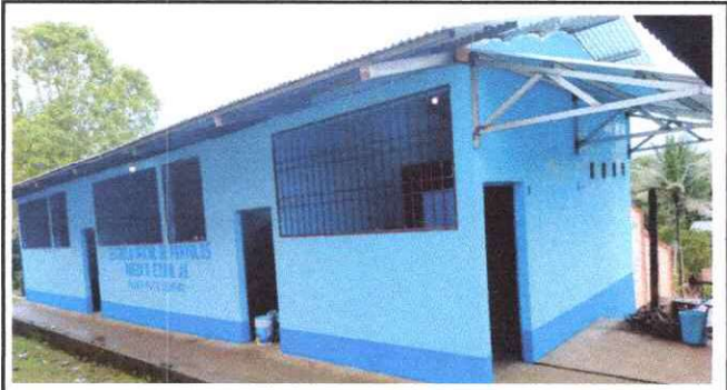
Foto 2: PINTURA EN MUROS EXTERIORE E INTERIORES
