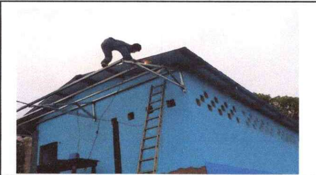
Foto 3: SUSTITUCIÓN DE LAMINA POR LAMINA TROQUELADA CALIBRE 26
