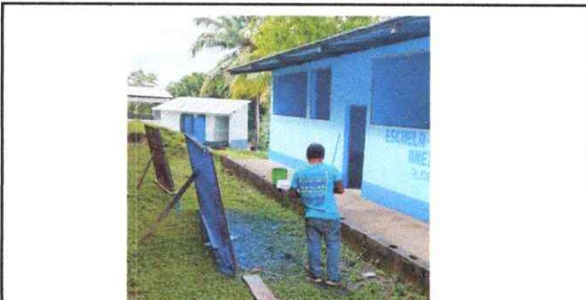
Foto 6: MANTENIMIENTO A BALCONES DE METAL
