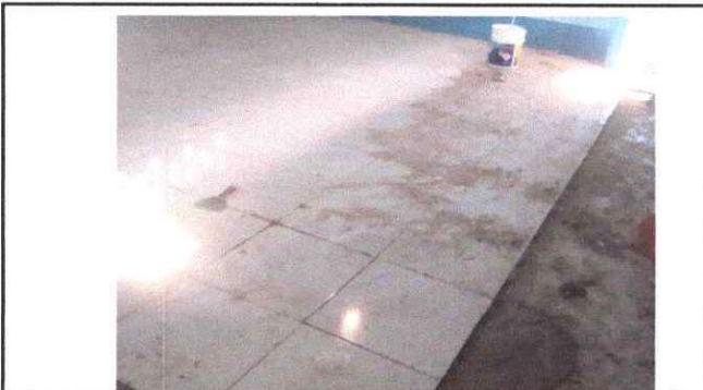
Foto 4: SUSTITUCION DE PISO CERAMICO POR PISO CERAMICO.
