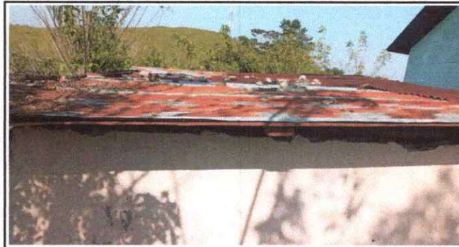
Foto 3: SUSTITUCIÓN DE LAMINA POR LAMINA TROQUELADA CALIBRE 26
