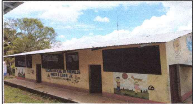
Foto 2: PINTURA EN MUROS EXTERIORE E INTERIORES
