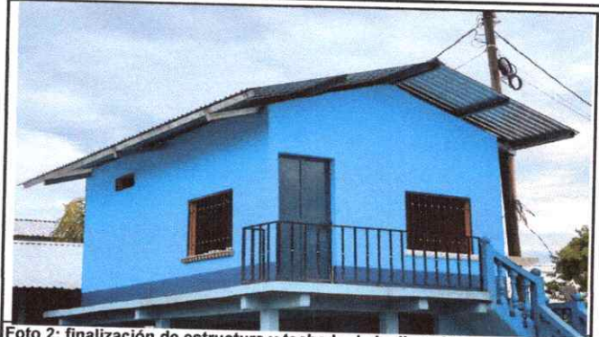
Foto 2: finalización de estructura y techado de la dirección
