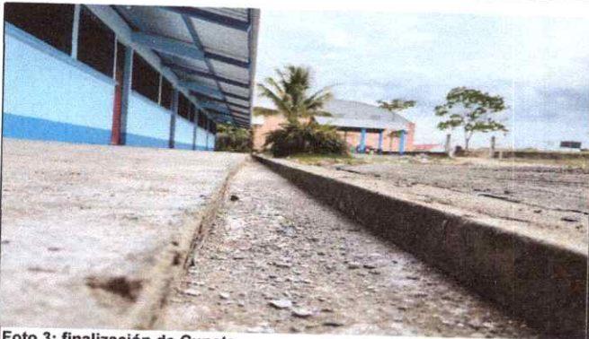
Foto 3: finalización de Cuneta
