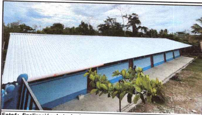
Foto1: finalización de techado
