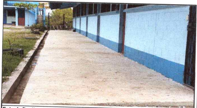
Foto 4: finalización de banqueta
